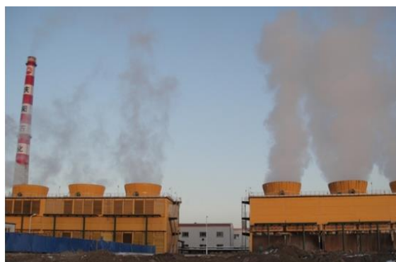
图2 庆阳石化工程新型塔（左侧）及常规塔（右侧）运行外观
